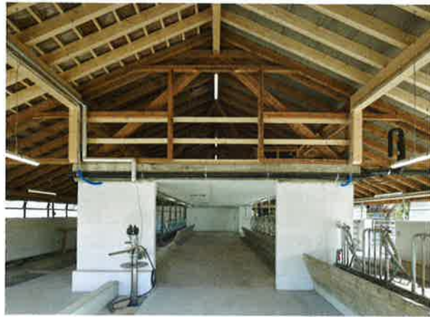
Der unbeheizte Kaltstall wurde um eine Achse verlängert. Dafür fanden die Holzbalken des rückgebauten Schopfs Verwendung.
