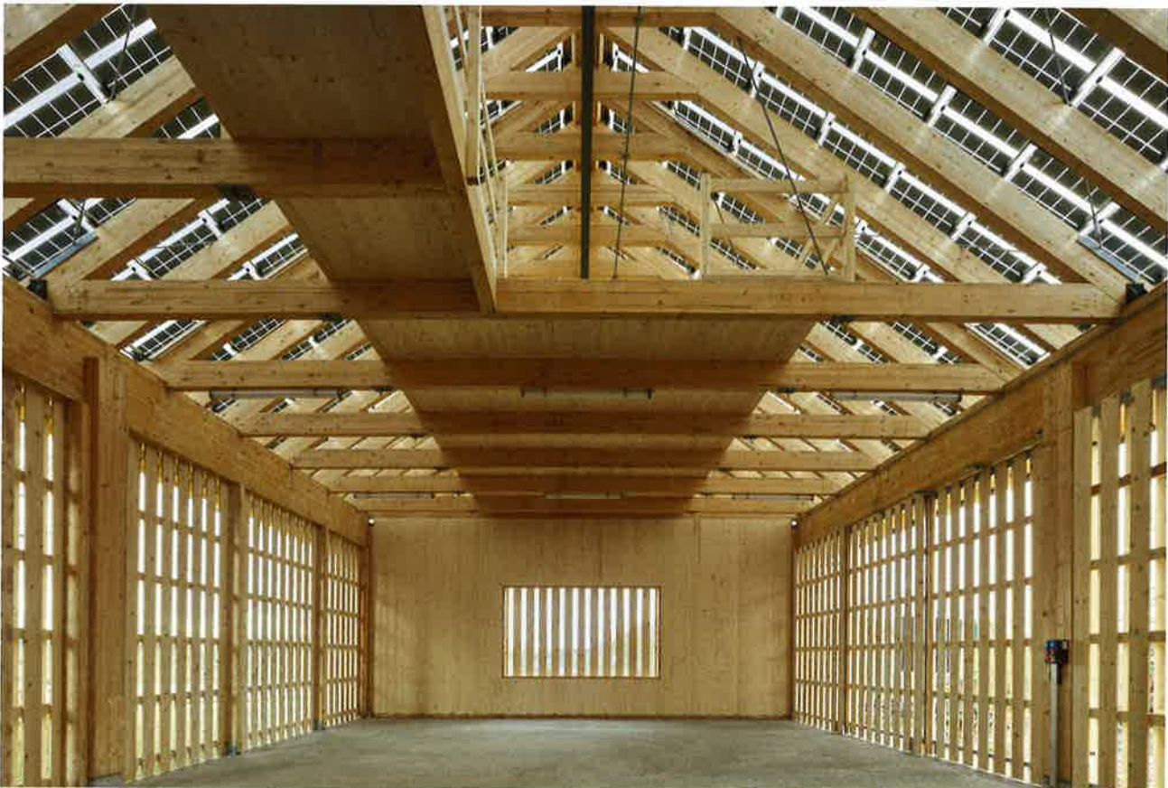
Für die Holzkonstruktion wurde ausschliesslich Holz aus dem Zürcher Staatswald verbaut. Die bestehende PV-Anlage auf dem Stallanbau wird neu durch die Indachanlage auf dem Ökonomiegebäude ergänzt. Sie besteht aus 300 Modulen.
