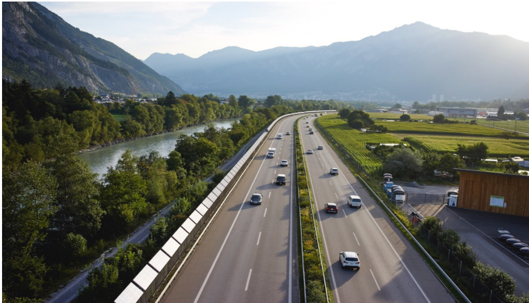
Bild PV Lärmschutzanlage, A13 Domat/Ems, TNC Consulting AG
