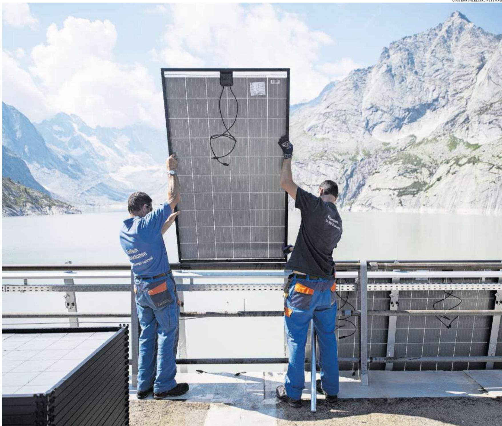
Monteure des Elektrizitätswerks der Stadt Zürich bringen eines von 1200 Solarpanels für eine Grossanlage am Albigna-Stausee im Bergell an. (10. August 2020)
