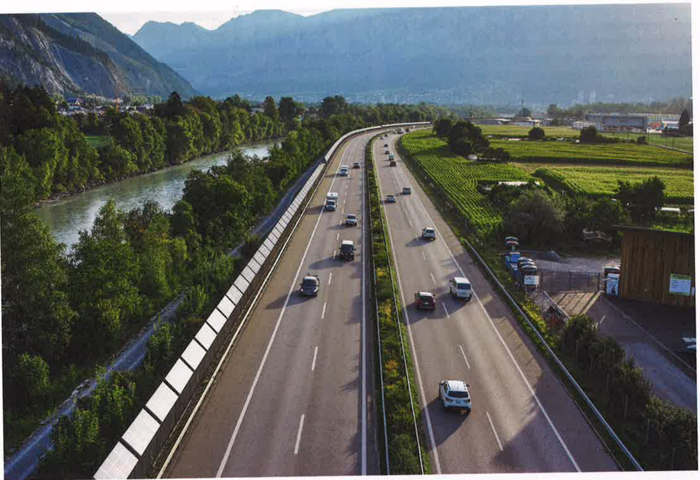
Luftaufnahme der Photovoltaikanlage aus dem Jahr 2015.
