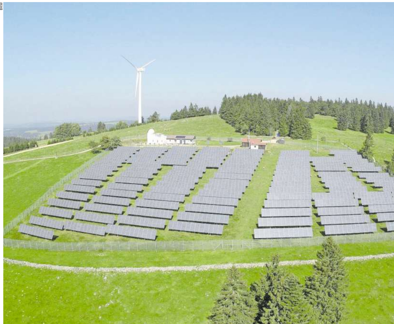
Eine der ältesten Freiflächenanlagen Europas: Sonnenkraftwerk «Mont-Soleil» im Kanton Jura.
