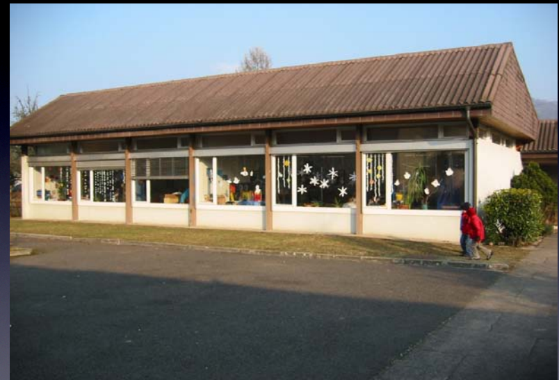
Kindergarten Oftringen, vor Erneuerung
