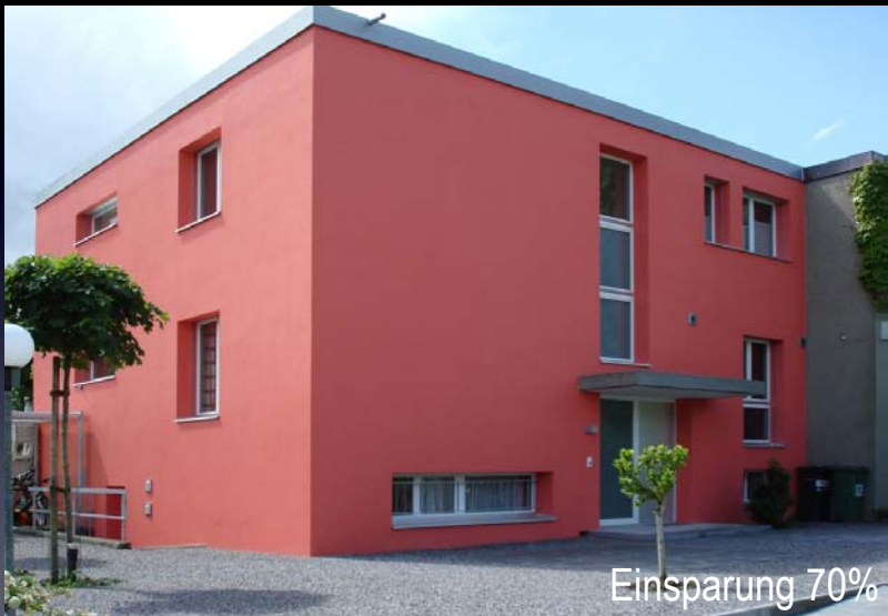
Mehrfamilienhaus nach Erneuerung
