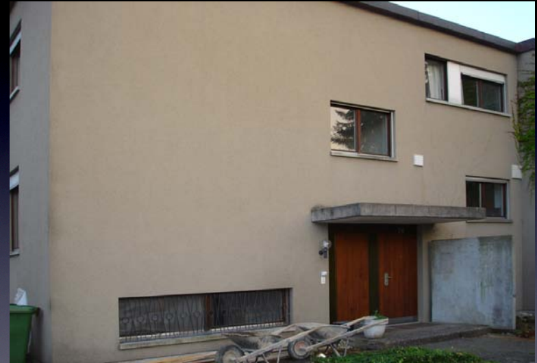
Mehrfamilienhaus vor Erneuerung
