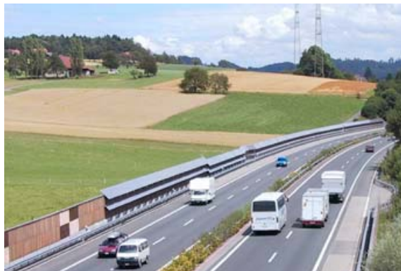
Abb. 1.7: Schindelanlage an der A2 bei Safenwil
