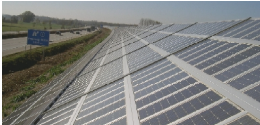
Abb. 1.15: Bei Freising (DE) realisierte Variante. Die Neigung des Schallschutz-Erddamms wurde für die parallel Anbringung einer Unterkonstruktion für die Photovoltaik-Anlage genutzt.
