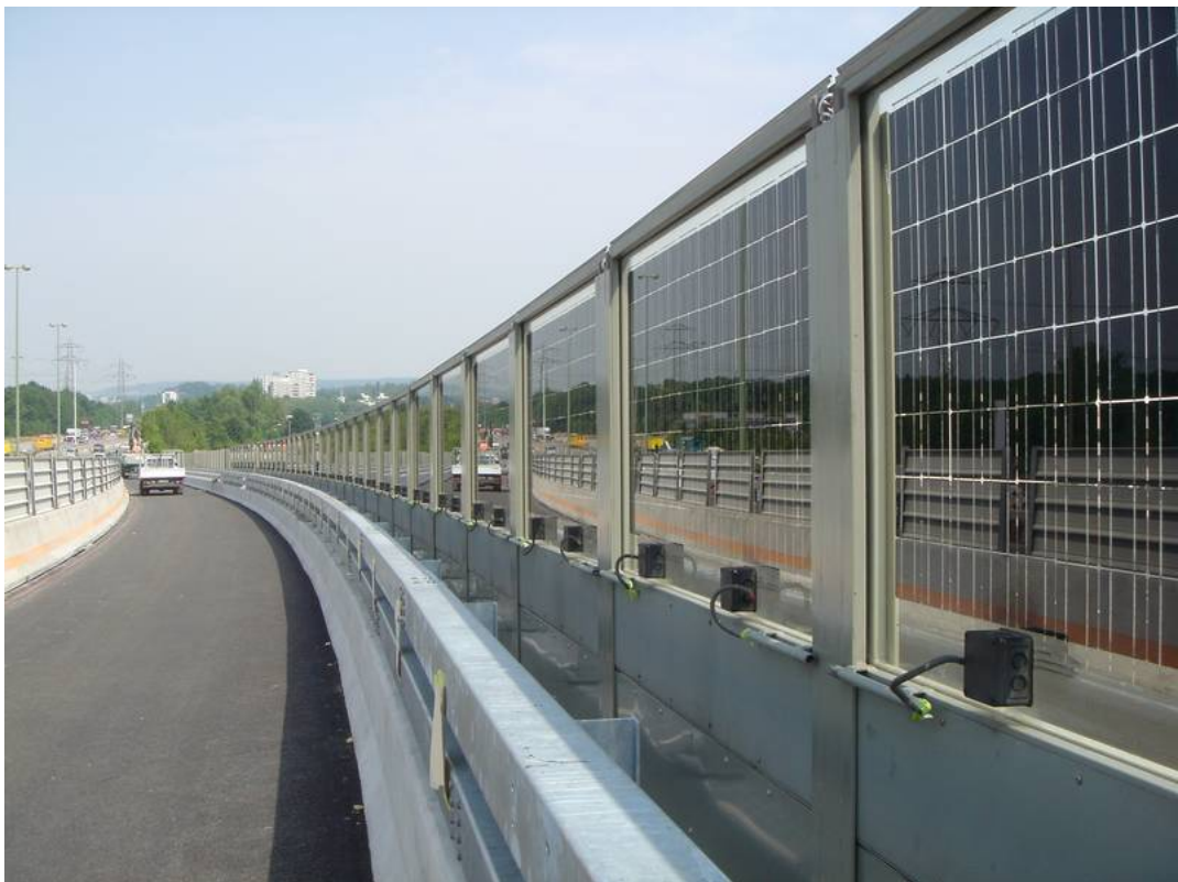
Abb. 3.7: Beispiel einer bifacialen PV Anlage entlang der N1 in Aubugg Kanton Zürich. Die strassenzugewandte Seite entspricht der Westseite.
