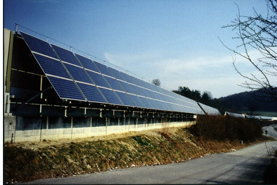
Abb. 1.5: An die strassenabgewandte Seite der Schallschutzwand angebaute PV-Anlage bei Giebenach BL
