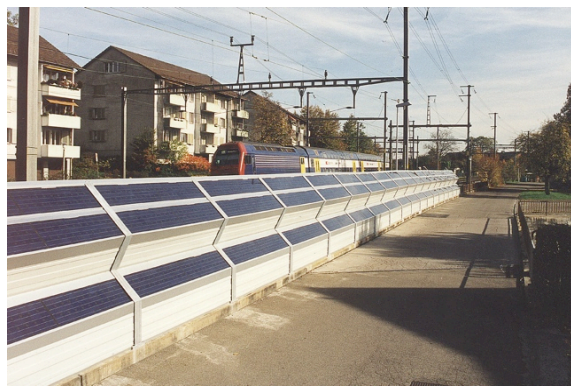
Abb. 1.9: Beispiel einer Zick-Zack-Anlage in Wallisellen entlang einer S-Bahn Linie. die Photovoltaik Module sind direkt in die schallabsorbierenden Metallkassetten integriert
