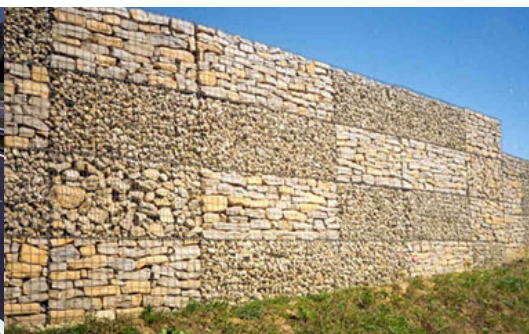
Abb. 1.2: Steingabionen als Lärmschutz
