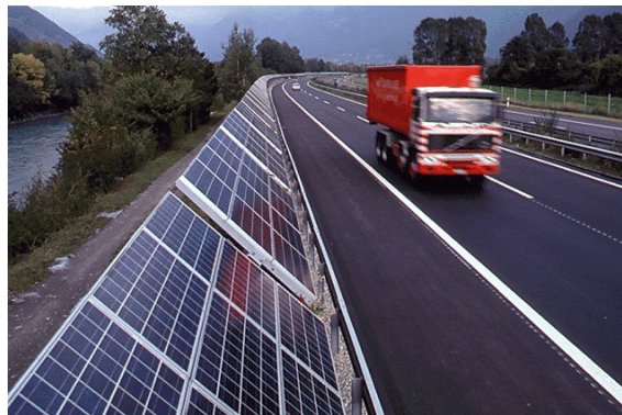
Abb. 1.4: Auf die bestehende Lärmschutzwand aufgebaute PV-Anlage an der A13 bei Domat/Ems nahe Chur
