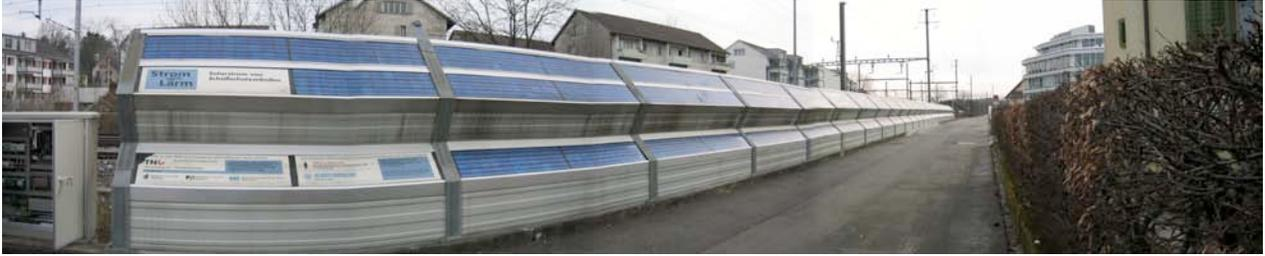
**Bild 2: Photovoltaik-Schallschutz an der Bahnlinie CH**
