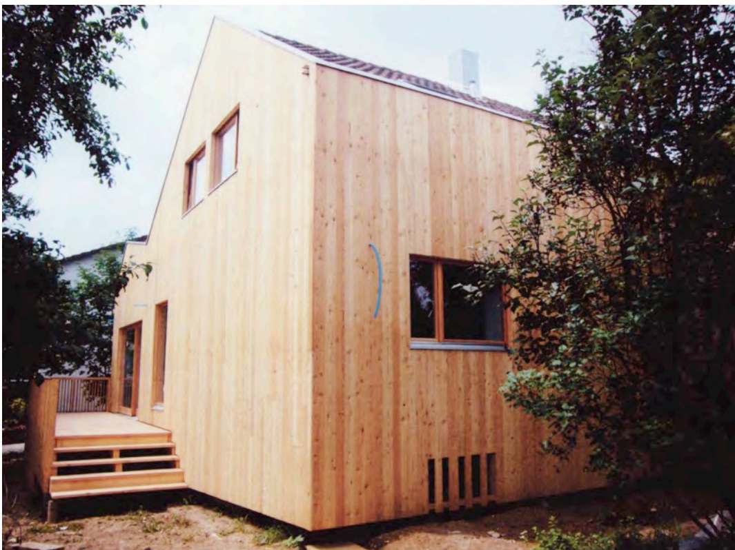
Wohngebäude, nach Erneuerung
