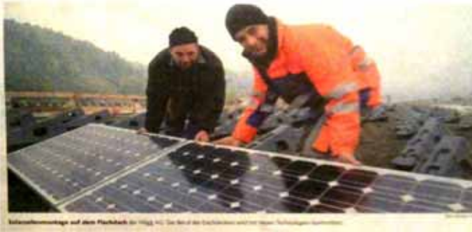
Solarstromanlage auf dem Flachdach der Hogg AG. Die Arbeit der Fachfirma wird vom St. Galler Tagblatt dokumentiert.
