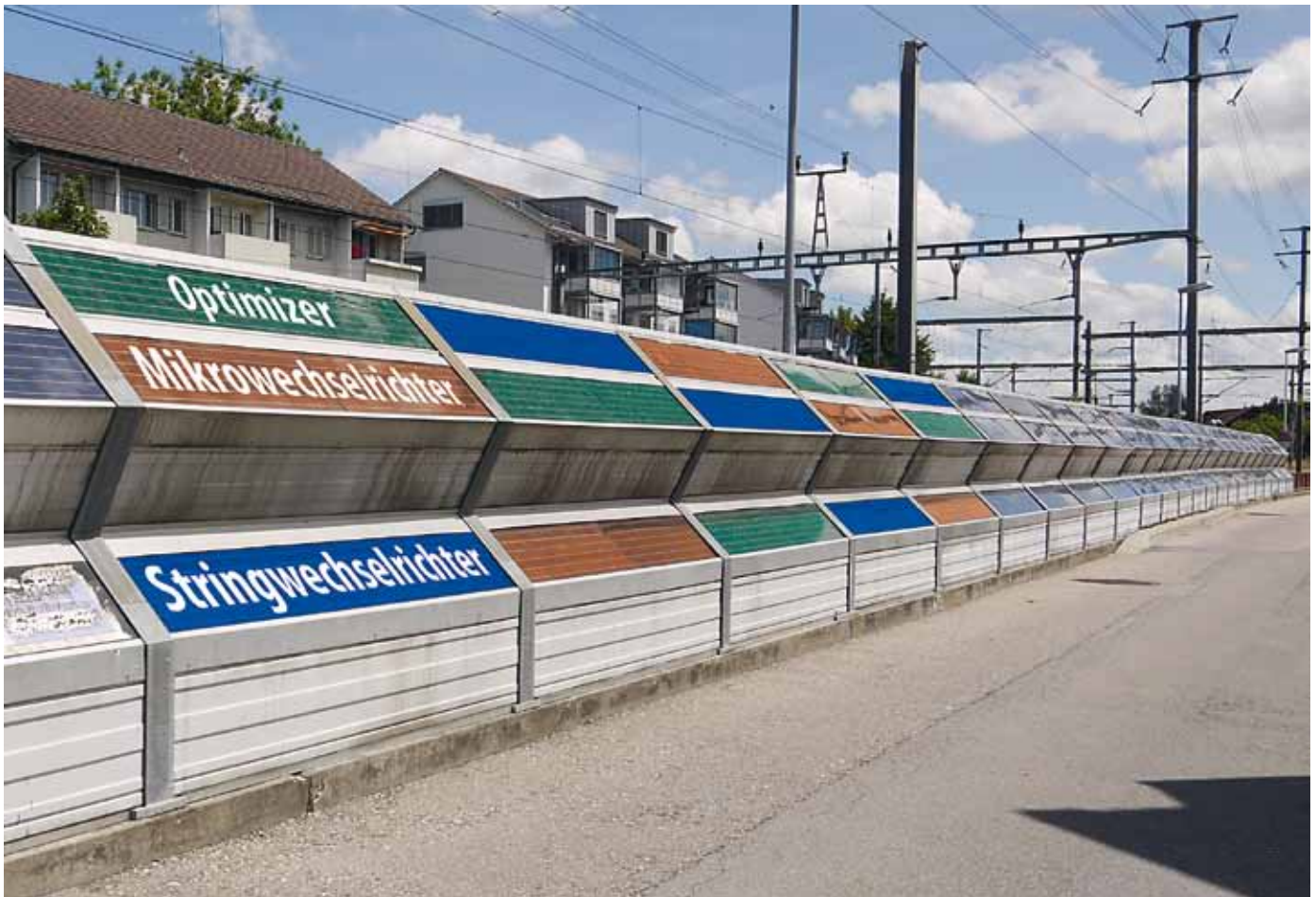
Direkter Vergleichstest am Bahnhof Wallisellen bei Zürich bei einer Photovoltaik-Schallschutzwand. Die Farben zeigen, welche Module zum Vergleichstest mit welchen Systemen ausgestattet wurden. Optimizer, Modulwechselrichter und Stringwechselrichter sollten die gleichen haben.
