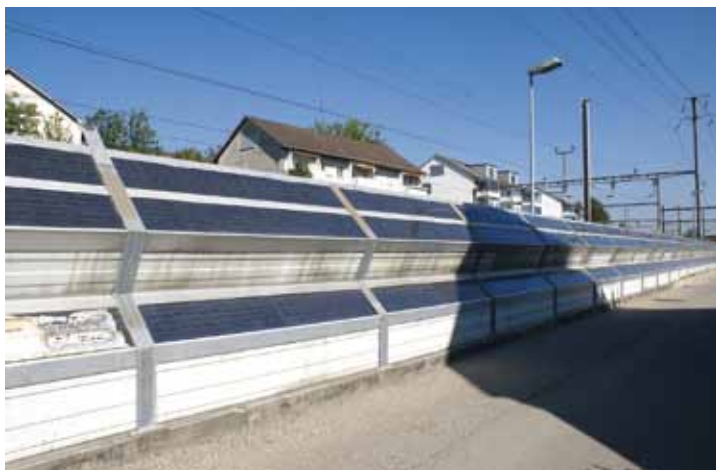
Die Schatten wandern auf den Modulen (links: Mitte September, 14:00 Uhr; rechts: Ende Januar, 16:00 Uhr).
